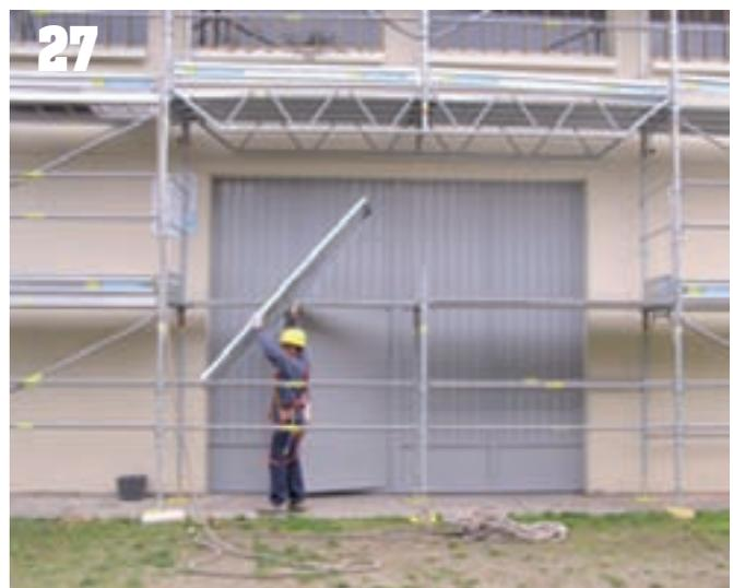
▲ Terminata la posa in opera delle travi tralicciate e dell'intolato ad esse soprastante, si è proseguito con lo smontaggio della parte di ponteggio sottostante le travi, al fine di liberare l'apertura di accesso al capannone
