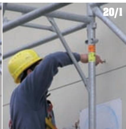
◀▲ Si provvede, quindi, a posizionare il primo ancoraggio; in questo caso un ancoraggio a tassello con l'anello in testata, sul muro portante in mattoni.
