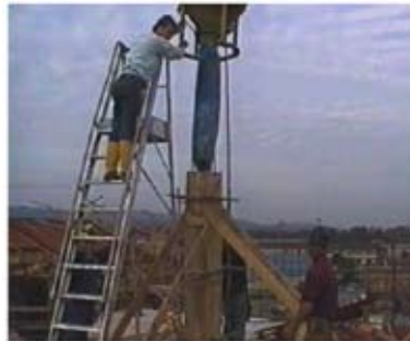
Immagine 05 Nell'uso delle scale a castello privilegiare quelle di altezza adatta alla lavorazione
