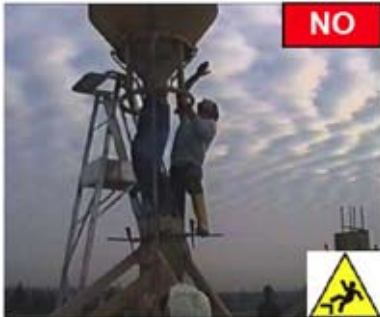
Immagine 04 Evitare getto pilastro, con uomo in quota sulle "cravatte"
