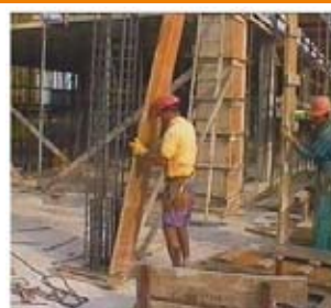
Immagine 01 Posa casseratura pilastro
