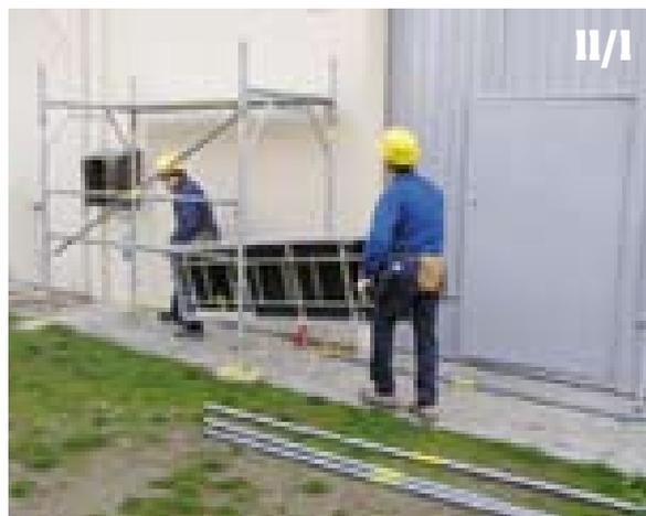
Trattandosi di un elemento unico con telaio in alluminio, pannello in compensato e scala di risalita incorporata, è necessario che almeno due persone provvedano alla sua messa in opera. ▶
