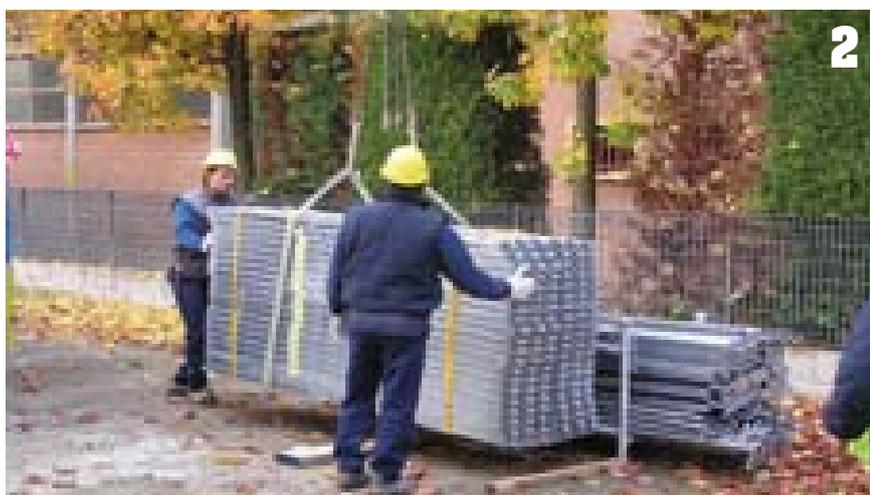
▲ Arrivo del 1° camion davanti alla Scuola con il ponteggio metallico fisso e avvio dell'attività di scarico del materiale da camion: sia sul camion che a terra il materiale viene posizionato in modo da velocizzare l'azione di successiva movimentazione e renderla altresì più sicura tramite appositi contenitori.
