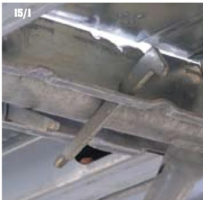
▲ La messa in opera delle tavole metalliche, eseguita dall'intavolato sottostante già parapettato, deve sempre essere accompagnata dall'inserimento dei perni di bloccaggio al traverso sottostante (in fig. meccanismi di blocco della tavola al traverso sottostante debitamente inseriti). ▲
