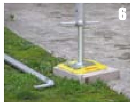
Si inizia quindi a montare le cavalle del ponteggio: per la labilità della struttura sono necessarie, in questa fase, almeno due persone, fino a quando non sono stati posizionati i successivi correnti e diagonali di irrigidimento. ▶
