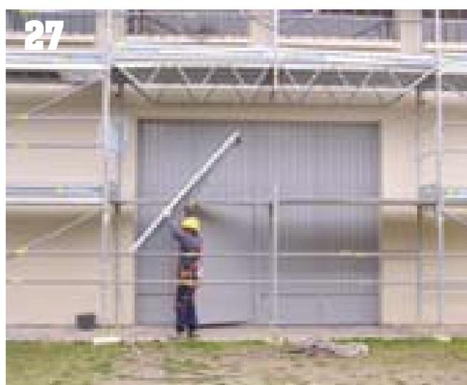
▲ Terminata la posa in opera delle travi tralicciate e dell'intavolato ad esse sovrastante, si è proseguito con lo smontaggio della parte di ponteggio sottostante le travi, al fine di liberare l'apertura di accesso al capannone.
