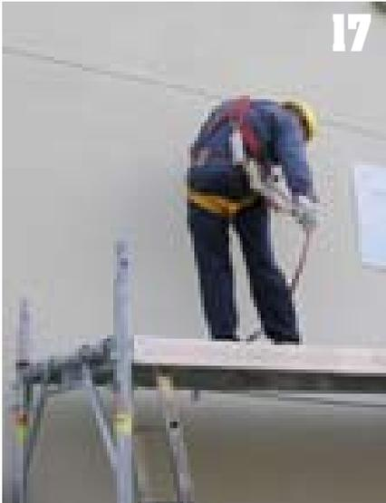
▲ A questo punto l'operatore può salire al piano superiore attraverso la botola dell'intavolato e, appena uscito dalla botola si lega alla fune di trattenuta. L'operatore provvederà quindi a far sì che la fune di trattenuta passi attraverso la parte interna dei montanti, al fine di garantire che il moschettone con il cordino dell'operatore possa traslare liberamente senza bloccarsi in corrispondenza di ogni montante.
