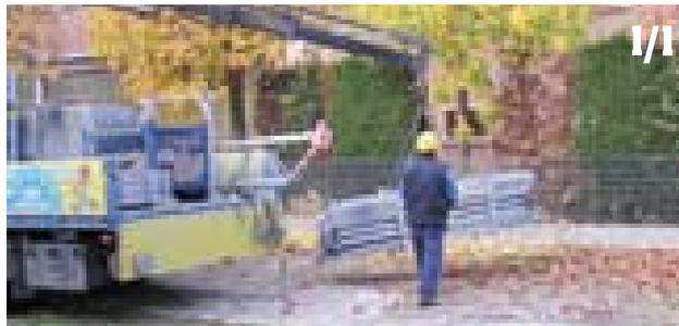
1 Arrivo del primo camion davanti alla Scuola con il ponteggio a telai prefabbricati e avvio dell'attività di scarico del materiale da camion: sia sul camion che a terra il materiale viene posizionato in modo da velocizzare l'azione di successiva movimentazione e renderla altresì più sicura tramite appositi contenitori.
