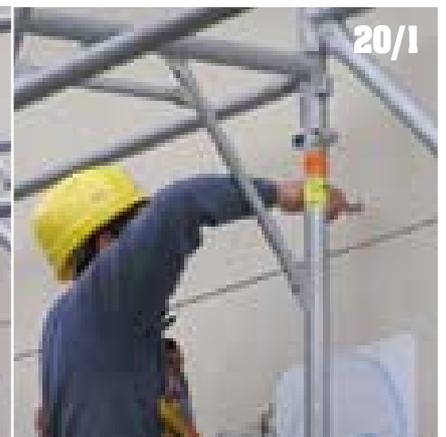
▲ Si provvede, quindi, a posizionare il primo ancoraggio; in questo caso un ancoraggio a tassello con l'anello in testata, sul muro portante in mattoni.
