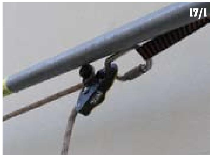
▲ Gli anelli nastrati (conformi UNI EN 795 classe B) vengono annodati attorno ai montanti con un nodo Prusik secondo le veloci tecniche alpinistiche; agli anelli nastrati viene quindi collegato la fune di trattenuta tramite moschettoni e specifico tensionatore. Per quel che è possibile, la fune viene quindi messa in tensione, dalla parte sottostante, con lo specifico tensionatore.
