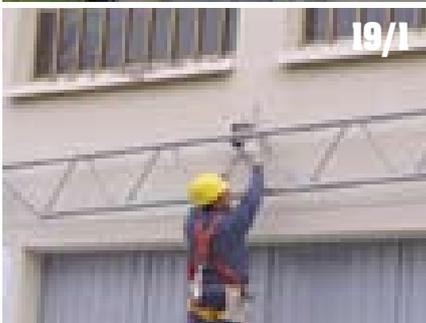
▲ Ponendo attenzione agli elementi di facciata (faro illuminazione) si pone in opera anche la trave tralicciata, che funge da portale per l'accesso del capannone (il ponteggio sottostante, realizzato temporaneamente per la messa in opera della travi tralicciate, verrà poi rimosso).
