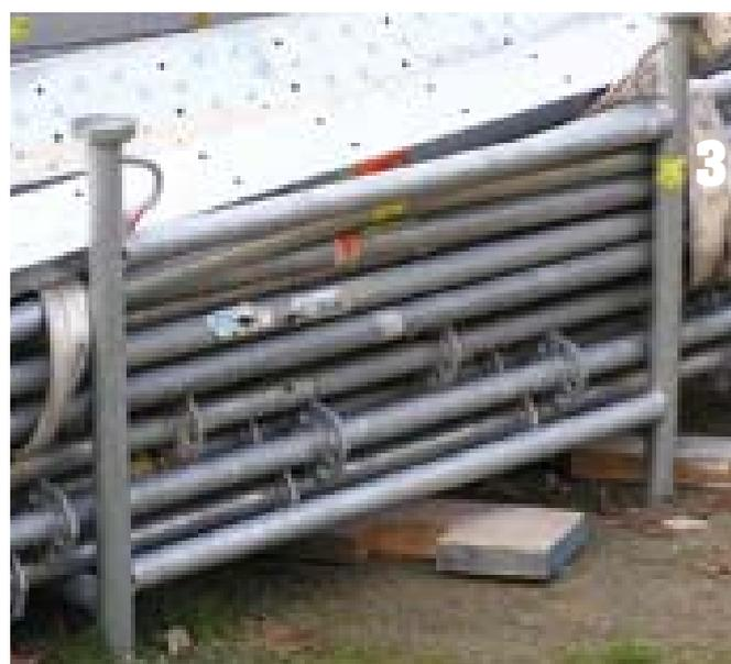
▲ Gli elementi ingombranti, quali i montanti del ponteggio, vengono sollevati in specifici contenitori.
