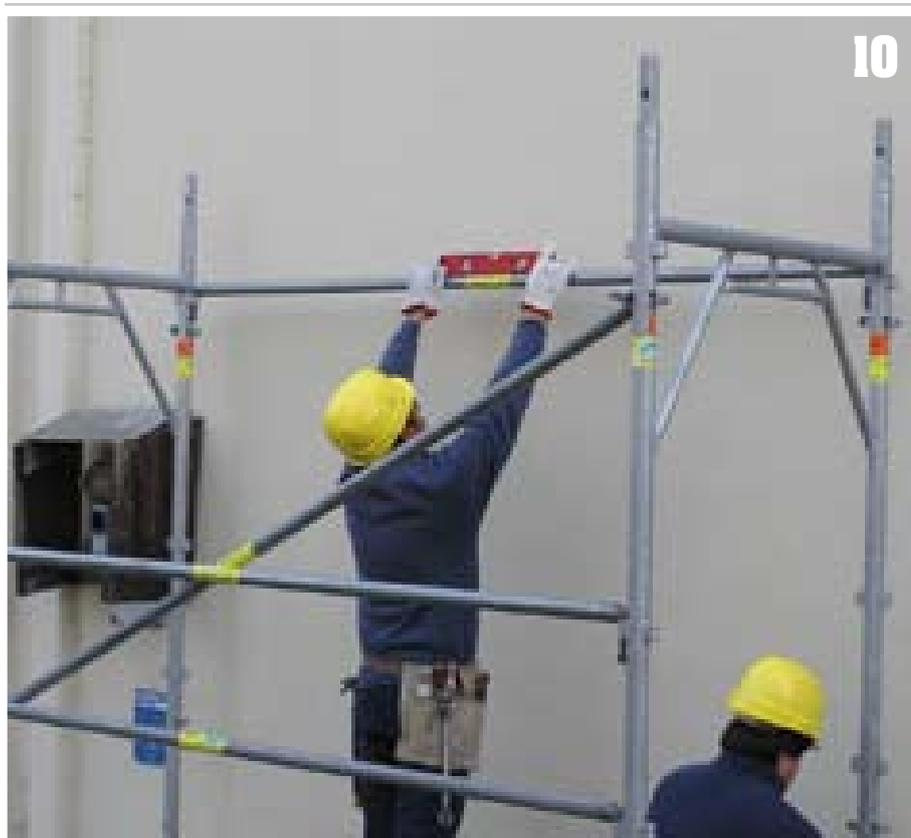
▲ Dopo aver posizionato i montanti e i traversi si procede alla messa in bolla (in orizzontale) dei telai: questa operazione va fatta scrupolosamente poiché determina la verticalità dei montanti, condizione a sua volta fondamentale per l'intera stabilità del ponteggio. La verifica della messa in bolla prosegue nelle varie parti dei telai, provvedendo alla messa in orizzontale attraverso la regolazione delle basette.
