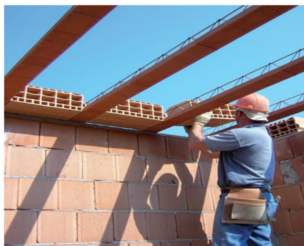
Immagine 06 - 07 posa travetti e pignatte con uso ponte su cavalletti sottostanti il solaio
