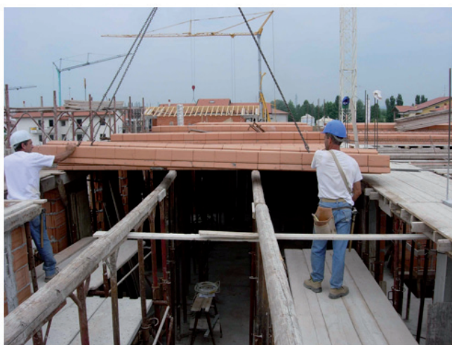
Immagine 06 - 07 posa travetti e pignatte con uso ponte su cavalletti sottostanti il solaio
